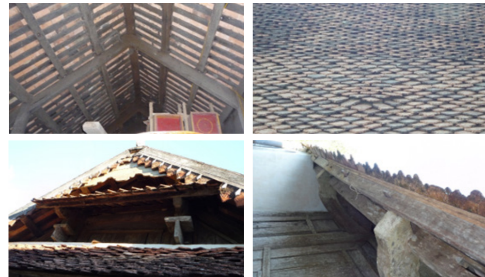
Kết cấu mái chống nóng trong nhà ở vùng Thanh Chương, Nghệ An
